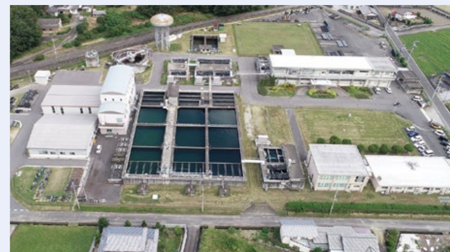
川添浄水場 ※写真提供:香川県広域水道企業団
